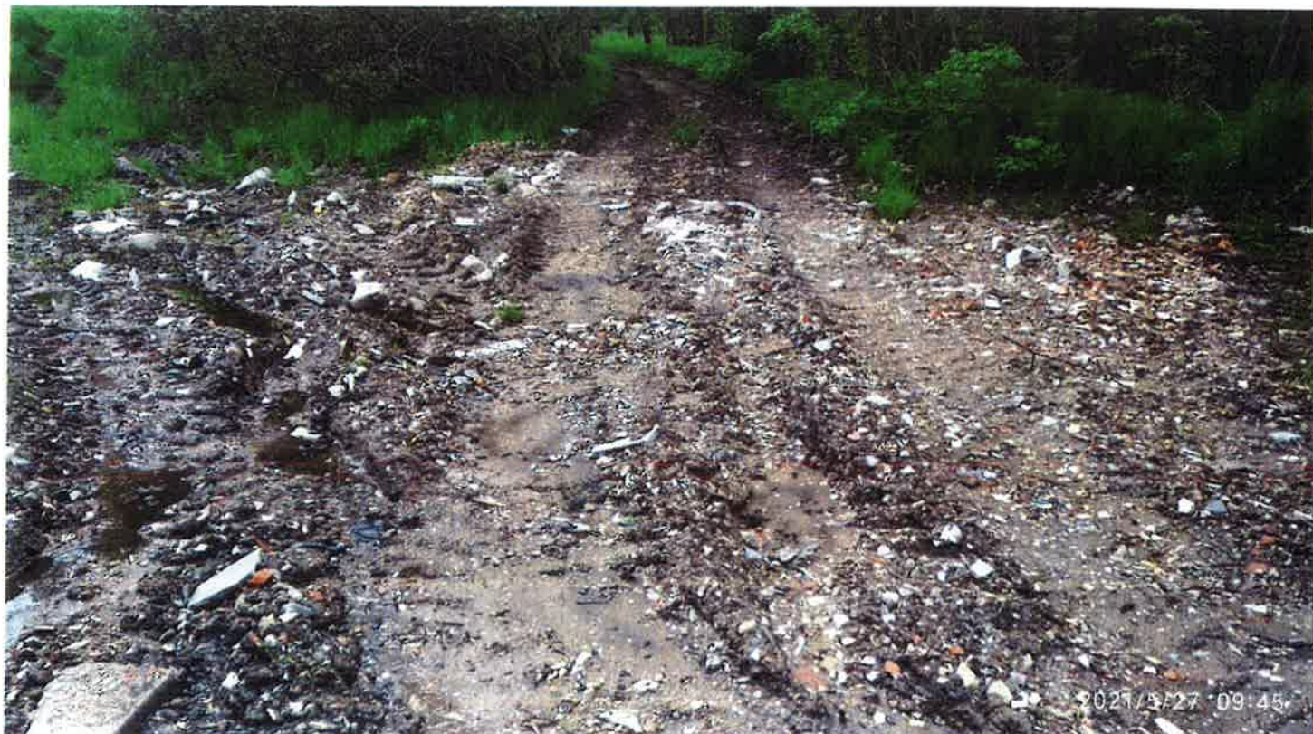
foto č. 8 – 9: směsné demoliční odpady navezené a rozhrnuté v cestě
