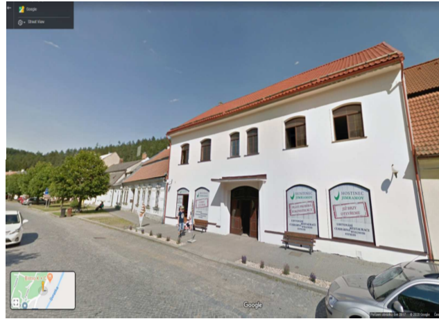
foto stávající stav
