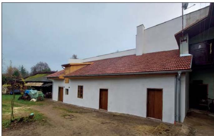
Opravený objekt domu č.p. 41
